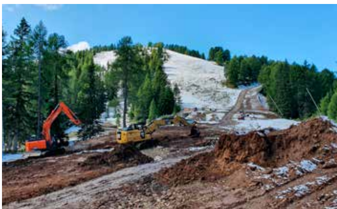
Pista Spolverino – lavori in corso
