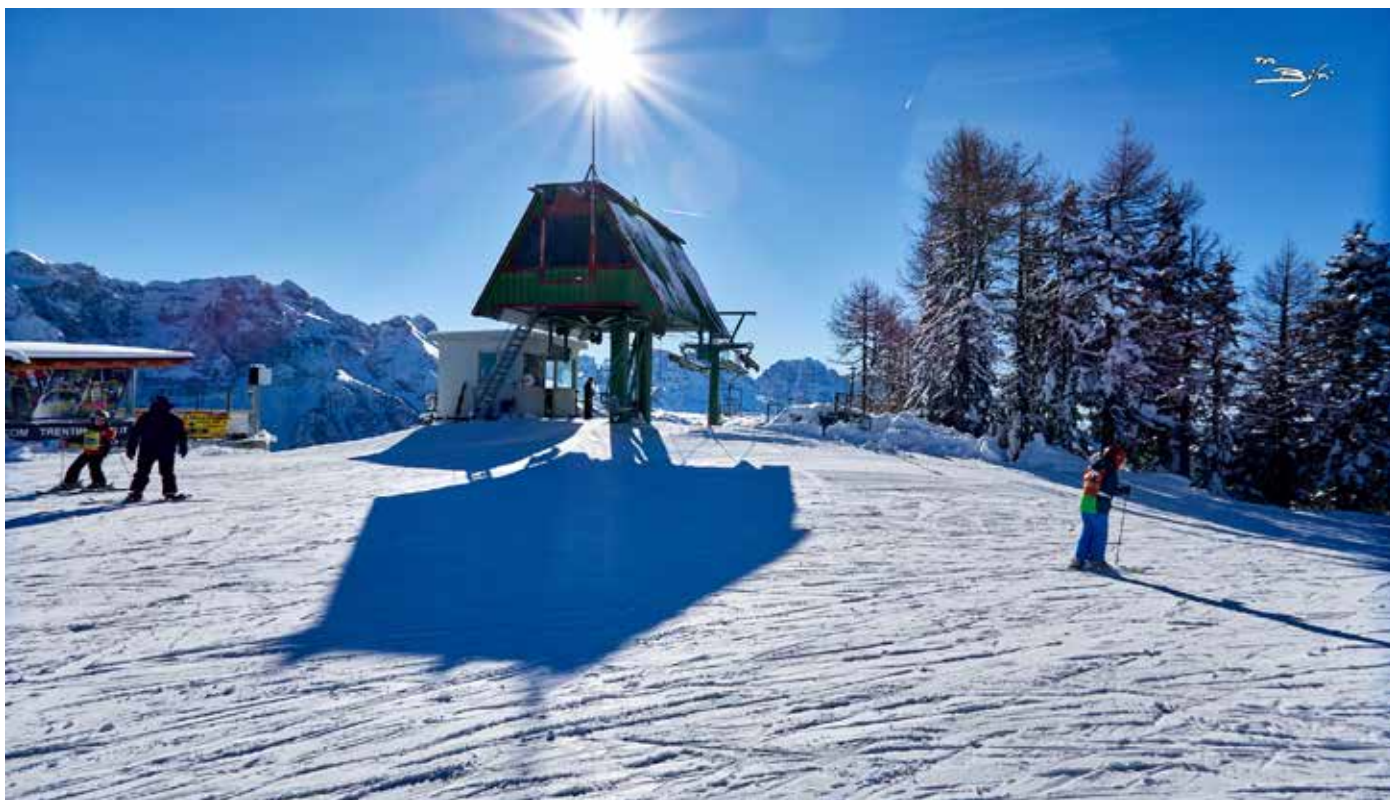
Seggiovia Bassetta, stazione di monte – come era
