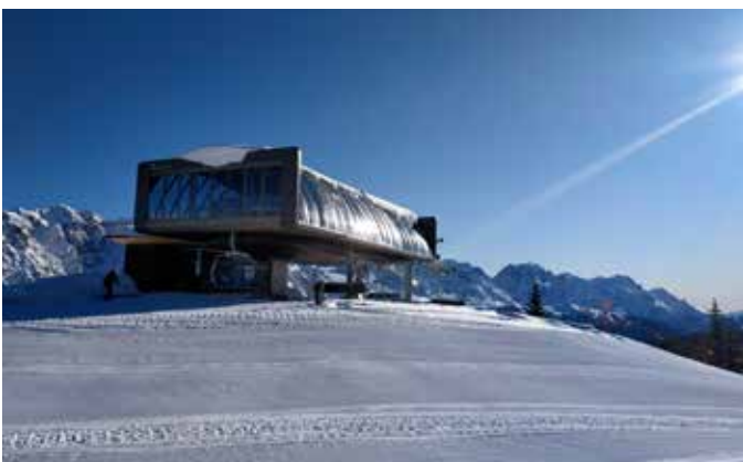
Nuovo impianto Bassetta – stazione di monte
