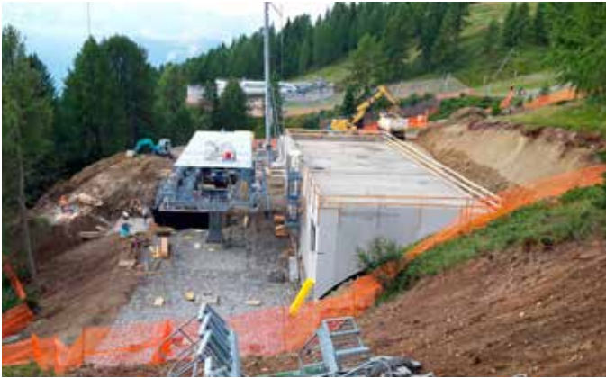
Stazione valle – lavori in corso
