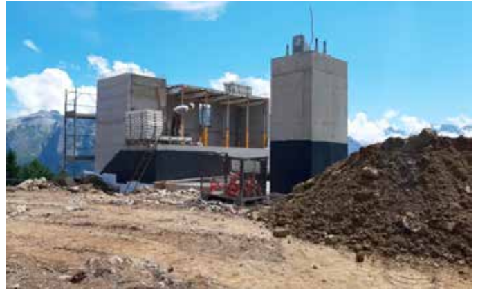
Stazione monte – lavori in corso
