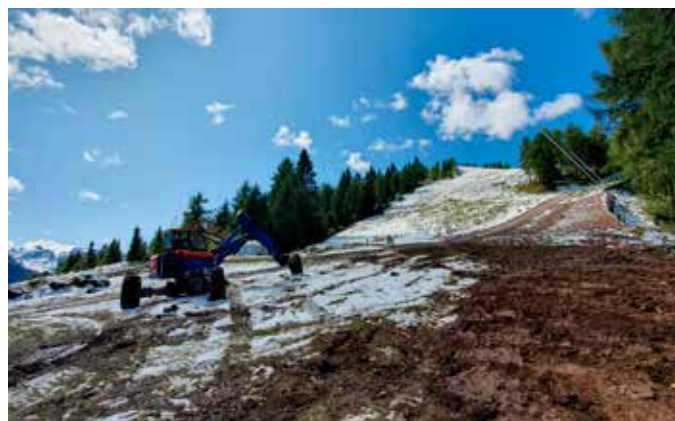
Pista Spolverino – lavori in corso
